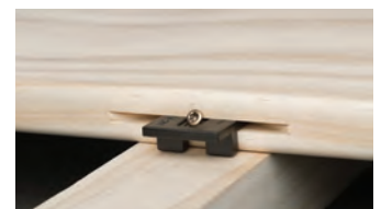
Rainurage local, à la fraiseuse à rainurer (de type Lamello®) ou à la défonceuse.
